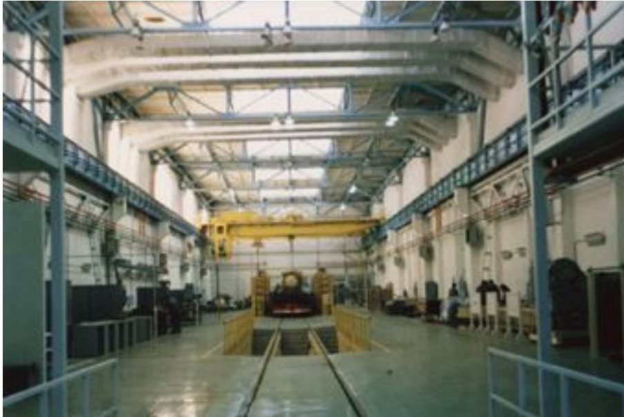
Fig. 5: Hala de montare / reparații
