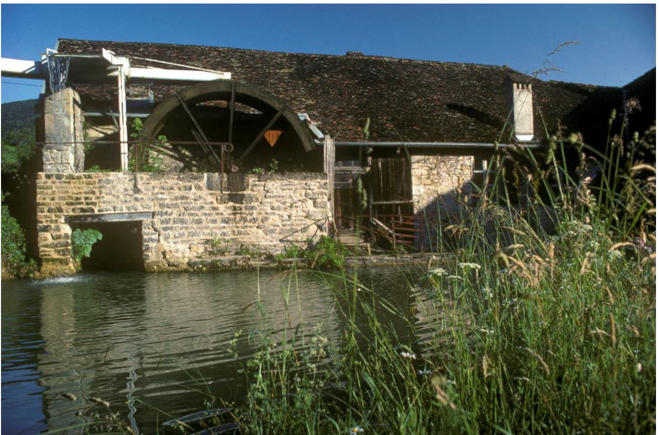
Photo 2 : Taillanderie de Nans-sous-Sainte-Anne, Doubs : réservoir et roue d'entraînement des soufflets de forge. ©Musées des techniques et cultures comtoises/Cl. G. Benoit à la Guillaume.)
