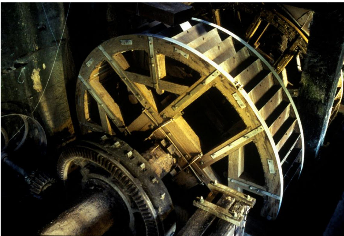
Photo 4 : Taillanderie de Nans-sous-Sainte-Anne, Doubs: cames et roue hydraulique à augets. ©Musées des techniques et cultures comtoises/Cl. G. Nivoix.
